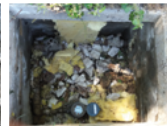
Slabo vzdrževan vodomerni jašek / Pozzetto del contatore in cattivo stato (Foto: RVK)
