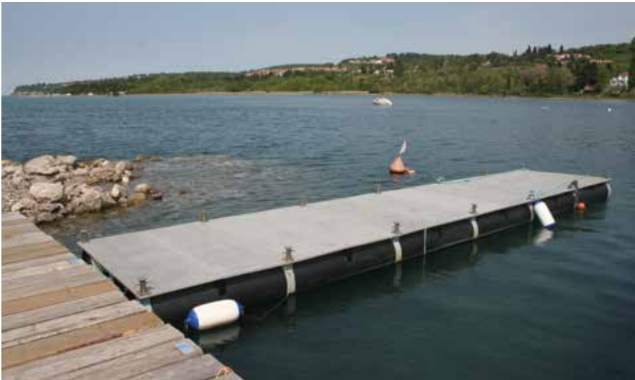
Kajakaši in kanuisti so pridobili novi splav preko katerega lahko varno spustijo kajake in kanuje v vodo. / Pontile galleggiante per la messa in mare sicura dei kayak e delle canoe. (Foto: Občina Ankaran / Comune di Ancarano)
