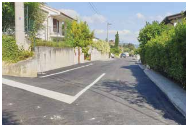
Sanirana občinska cesta na rožniku. / La strada di Roseto ristrutturata. (Foto: Uredništvo / La redazione)
