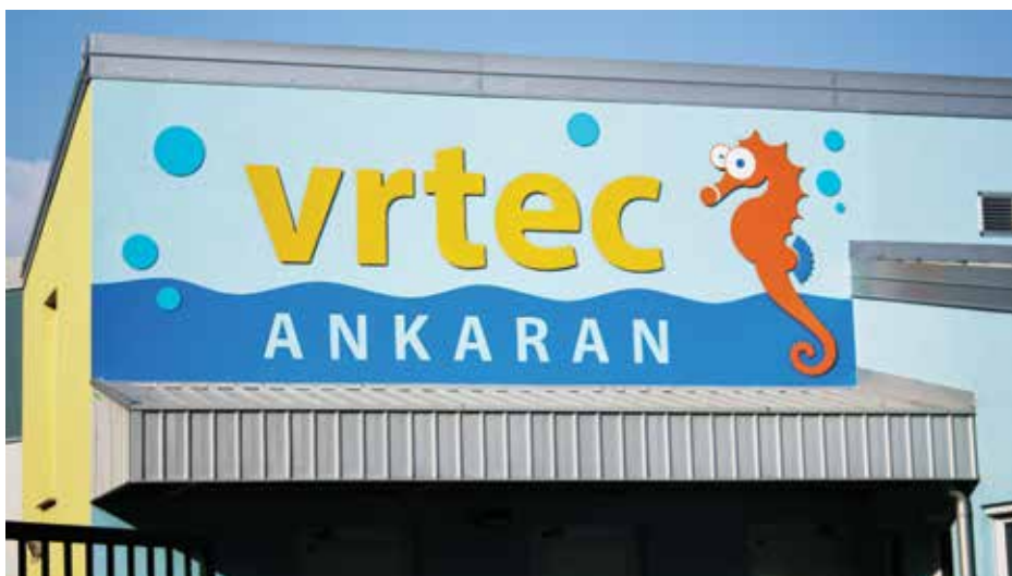
V ankaranskem vrtcu so čez poletje potekala sanacijska dela. / I lavori di ristrutturazione nell'asilo di Ankarano eseguiti durante l'estate. (Foto: OŠVA / SEA)
