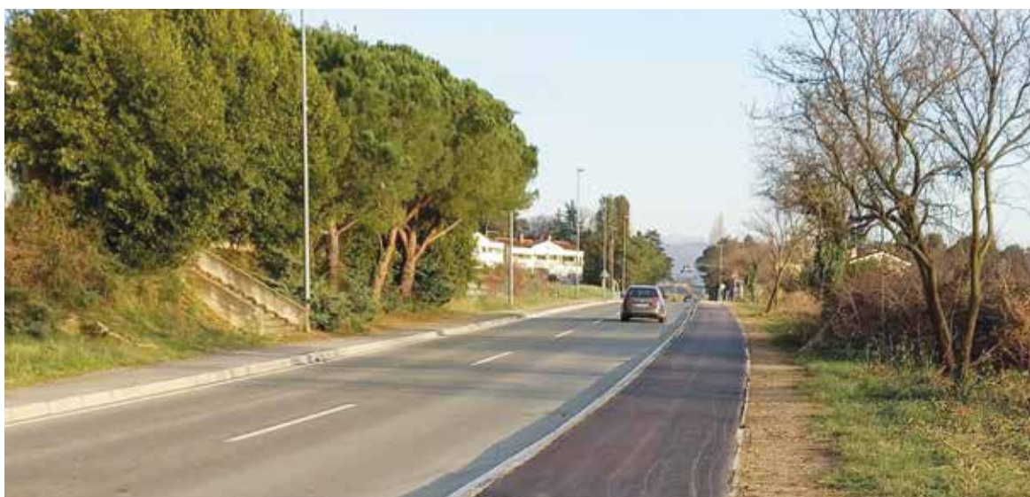
Zaradi načrtovane celovite rekonstrukcije je hodnik za pešce ob Jadranski cesti le prenovljen. / Il marciapiede lungo Strada dell'Adriatico è stato temporaneamente sistemato, dato che la ricostruzione completa è pianificata in futuro. (Foto: Uredništvo / La redazione)
