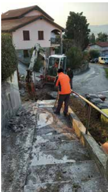
Občina Ankaran je poskrbela tudi za vgradnjo kabske kanalizacione za bodoče optično omrežje. / Il Comune di Ancarano ha provveduto all'installazione delle canalette per la rete ottica. (Foto: Občina Ankaran / Comune di Ancarano)
