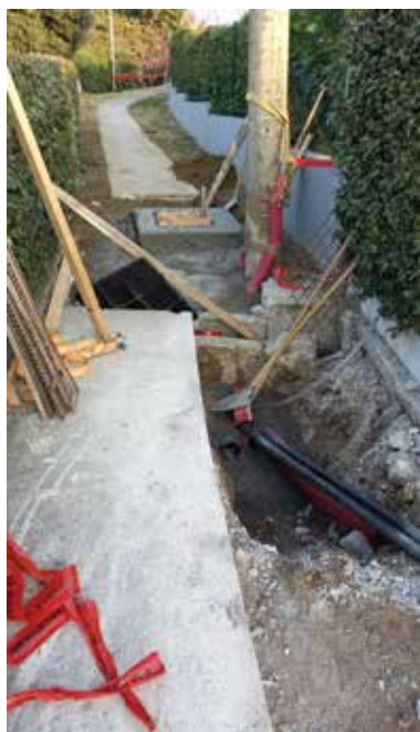
Občina Ankaran je poskrbela tudi za vgradnjo kabske kanalizacione za bodoče optično omrežje. / Il Comune di Ancarano ha provveduto all'installazione delle canalette per la rete ottica. (Foto: Občina Ankaran / Comune di Ancarano)
