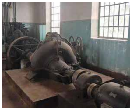
Slika I3.01-1 in I3.01-2: Črpališče so zgradili v značilni industrijski arhitekturi takratnega časa. Strojnica črpališča je sestavljena iz dveh dvovaljnih dizelskih motorjev in dveh črpalk.
