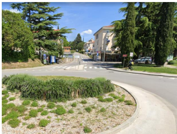
Slika 3: obstoječe krožišče na državni cesti R2-406/1407 s priključkom Regentove ulice
