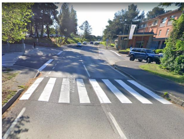
Slika 5: obstoječe križišče ob Valdoltri na državni cesti R2-406/1407 (Škofije - Lazaret)
