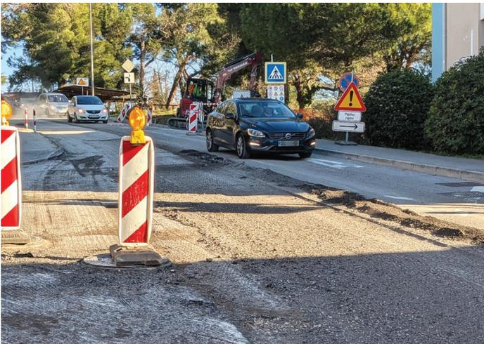
Začetna faza preplastitve Regentove ulice: rezkanje asfalta. / Fase iniziale del rifacimento del manto stradale di Via Regent: fresatura dell'asfalto.
