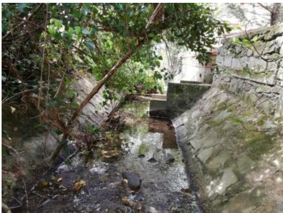
Slika 14: Odprta struga hudournika Ankaran dolvodno proti iztoku v morje
