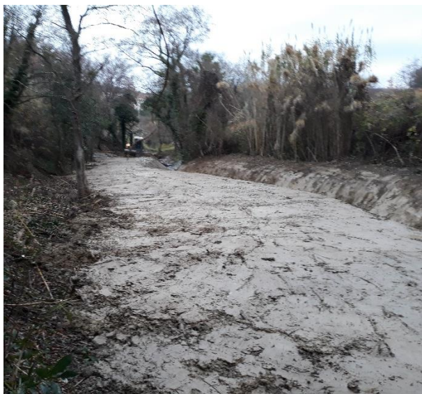
Slika 7: Struga hudournika Ankaran po iztoku iz prepusta
