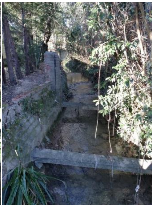
Slika 13: Odprta struga hudournika Ankaran s prečnimi ovirami
