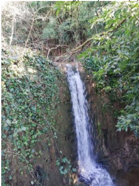
Slika 10: Pregrada na hudourniku Ankaran
