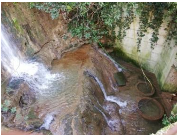
Slika 11: Umirjevalni bazen pred vtokom hudournika Ankaran v kineto
