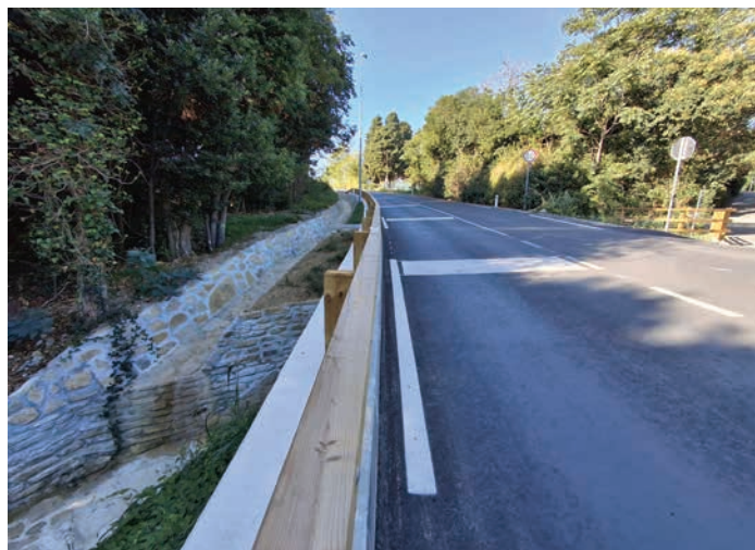
Na nevarnih mestih so bile postavljene lesene varovalne ograje. / Nei punti più esposti sono state installate barriere di sicurezza in legno.
