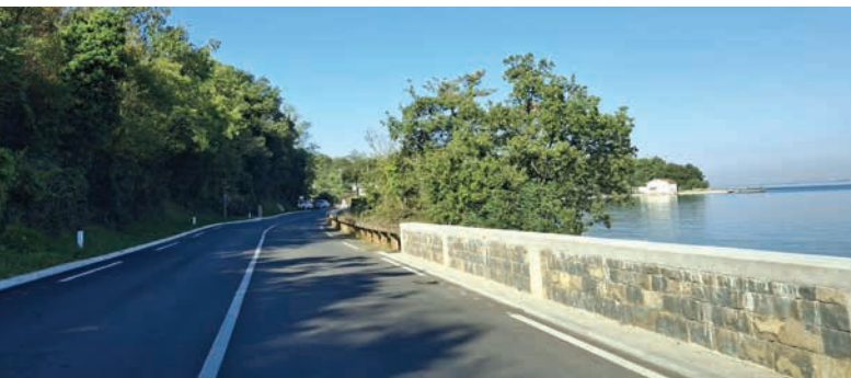
Lokacija enega od dveh novih podpornih zidov z ograjnim zidom iz peščenjaka. / Ubicazione di uno dei due nuovi muri di sostegno con rivestimento in arenaria.
